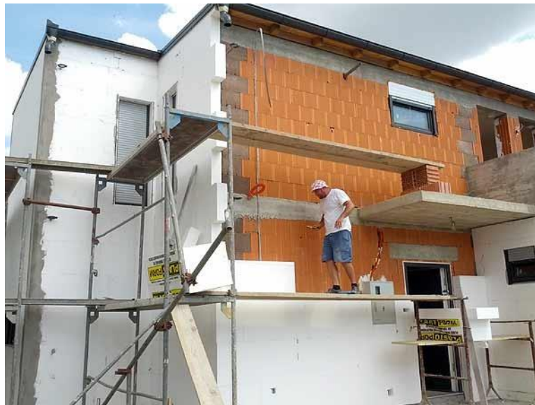
Polaganje toplotne izolacije iz stiroporja
